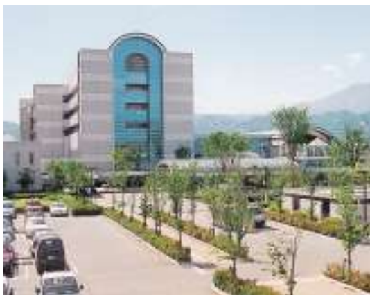
完成した長野市民病院
