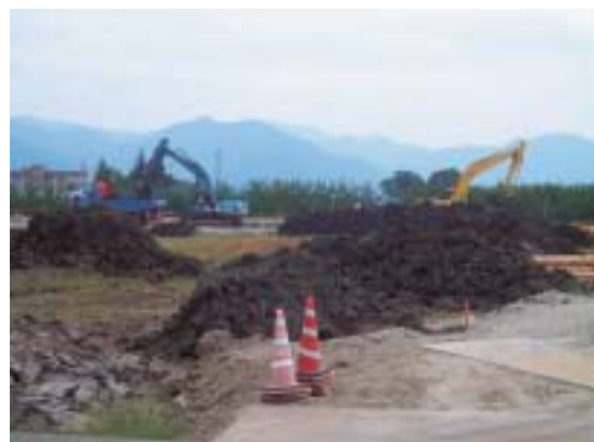
〈造成工事の様子〉
