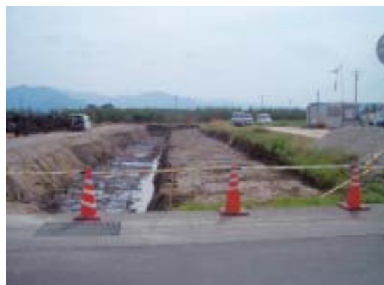
〈水路工事の様子〉
