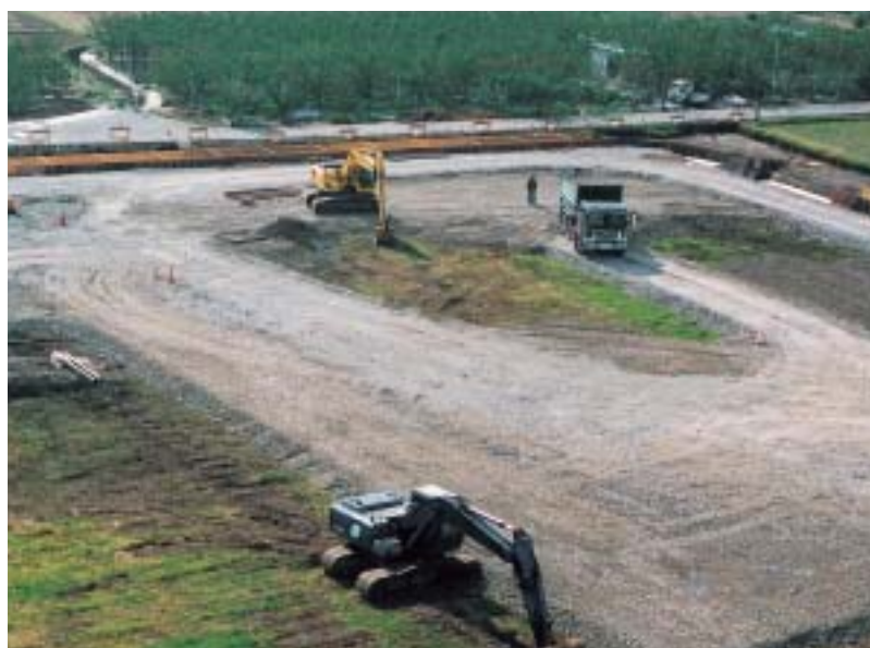
〈増床用地の造成工事〉
