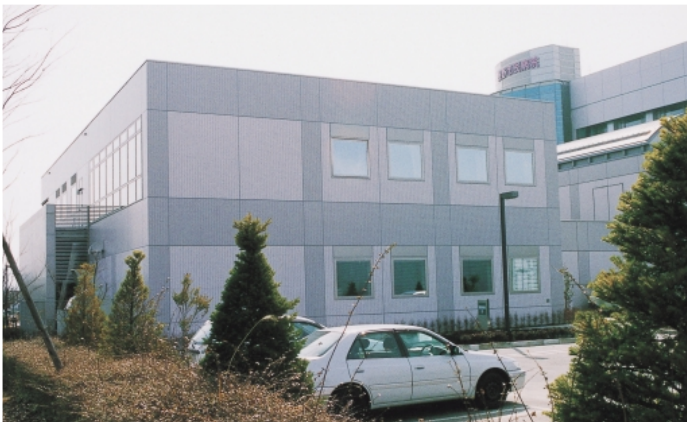
▲ 増築されたCT・MR棟
