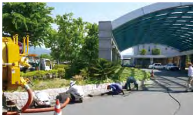
今回清掃作業していただいたのは、ロータリーや駐車場の雨水用排水路。
