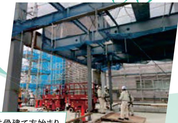
鉄骨建て方始まり
