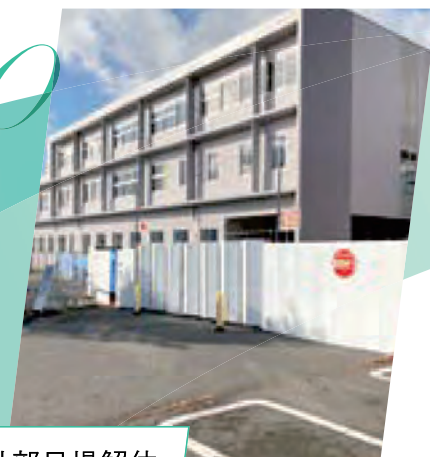
外部足場解体
