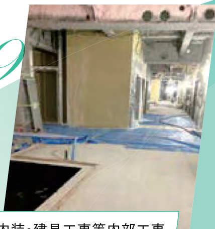
内装・建具工事等内部工事
