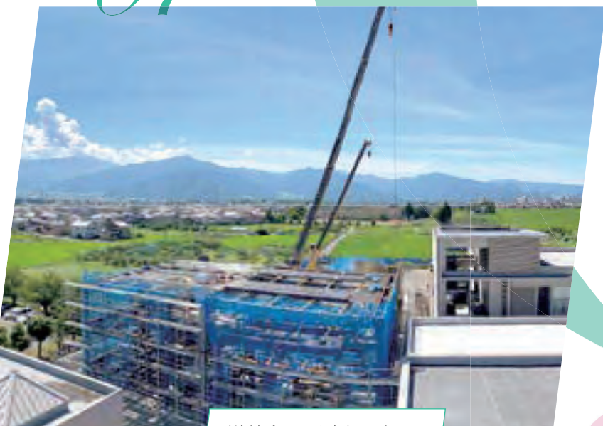
増築部分北側より撮影
