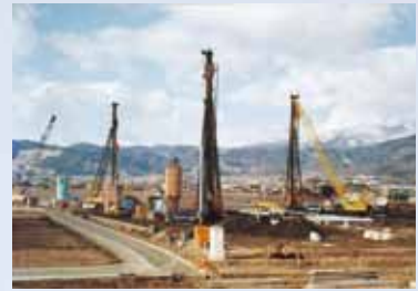
工事風景…平成5年
