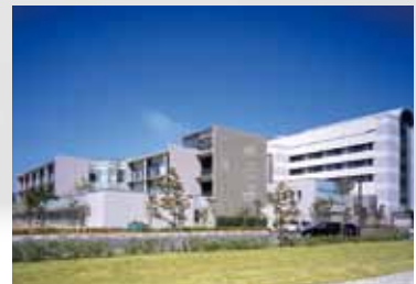
長野市景観賞「長野市民病院 中央棟、南病棟」…平成21年9月4日
