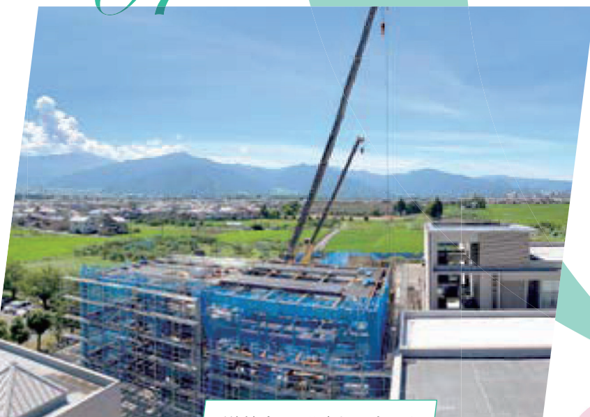
増築部分北側より撮影
