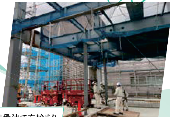
鉄骨建て方始まり
