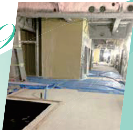
内装・建具工事等内部工事
