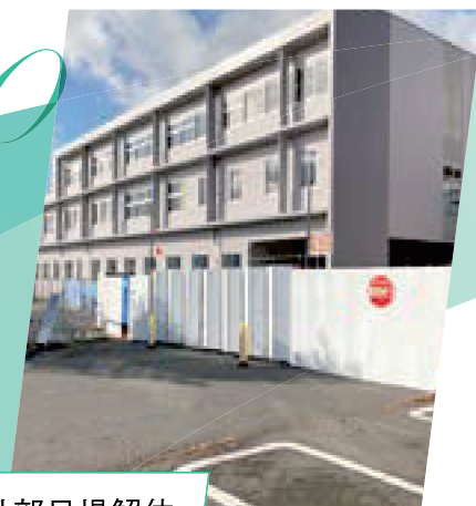
外部足場解体
