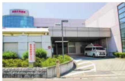
救急センター入口に救急車を配置
