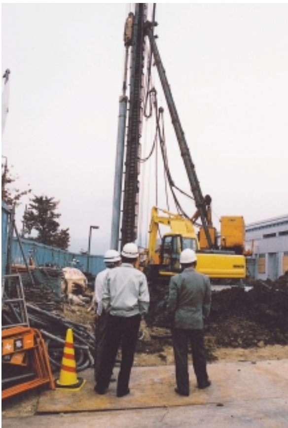
急ピッチで進むCT、MR関連増築工事
