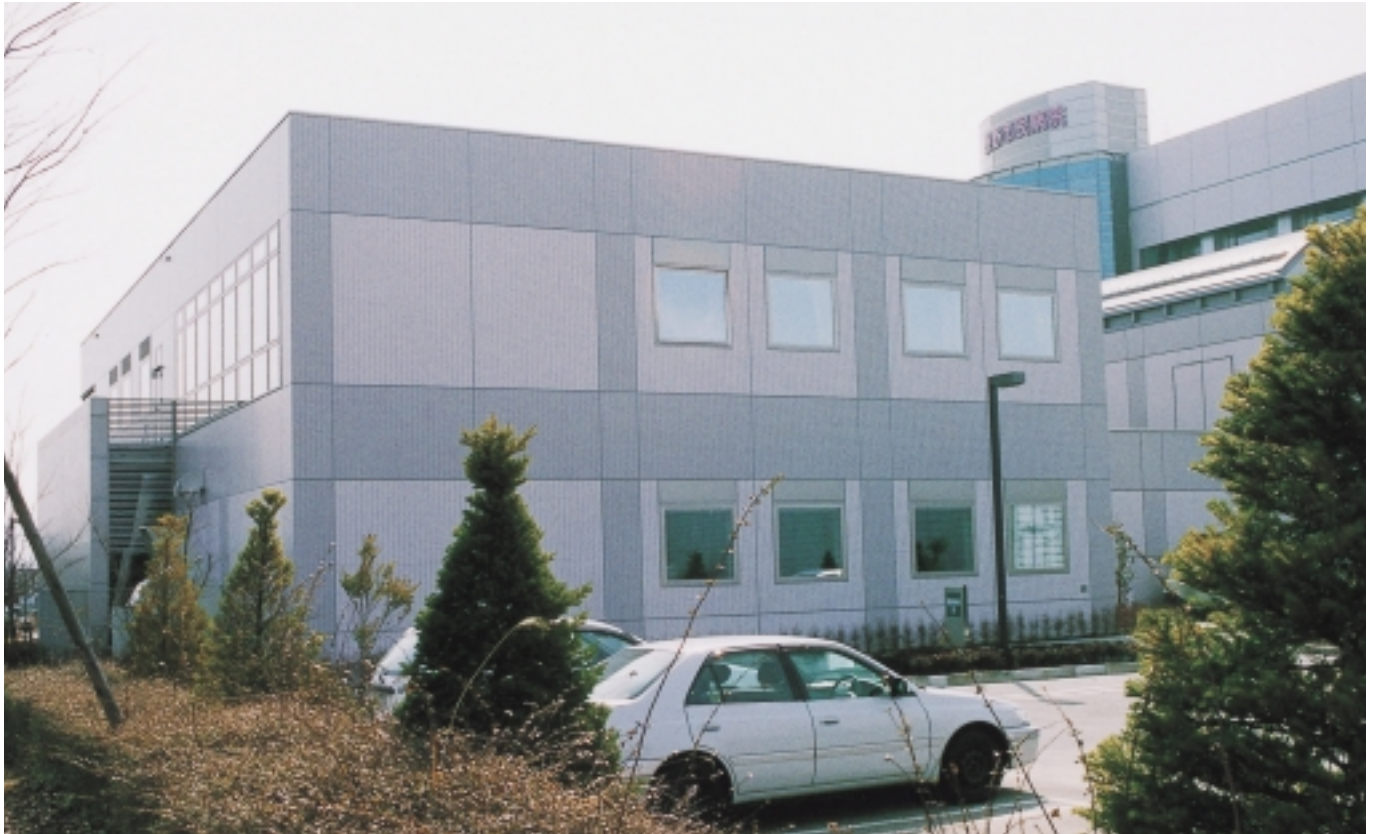
増築されたCT・MR棟
